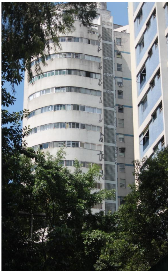
Figura 16 - Imagem tirada em 16/01/2016 no Acesso à Rua da Consolação
