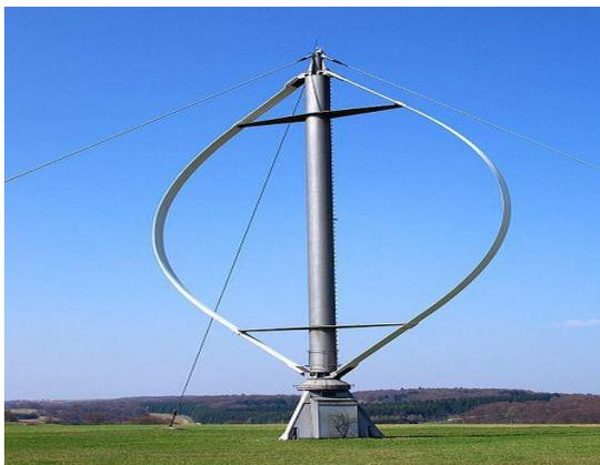
Figura 17 - Aerogerador – Eixo Vertical
