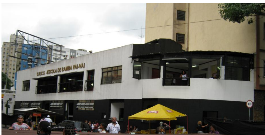
Figura 3 – Visão externa da quadra Fonte: Tirada pelo autor.
